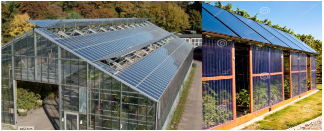
Esempi di serra fotovoltaica
